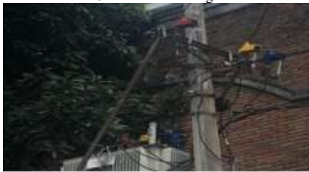
Gambar 14. Cover Pelindung FCO dan Bushing Trafo
